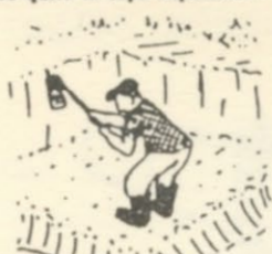
El material extraído se extiende, dejando 40 cms. de altura.
