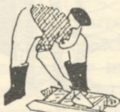
Se alisa la superficie, cuidando de recoger el exceso de barro.
