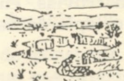
Haciéndose una excavación de 1 a 2 mts. de profundidad.
