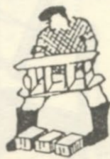
Quedando los adobes en el suelo.
