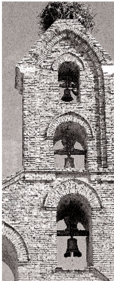
Remate de la espadaña de la iglesia de San Juan en Villalón de Campos (Valladolid)
