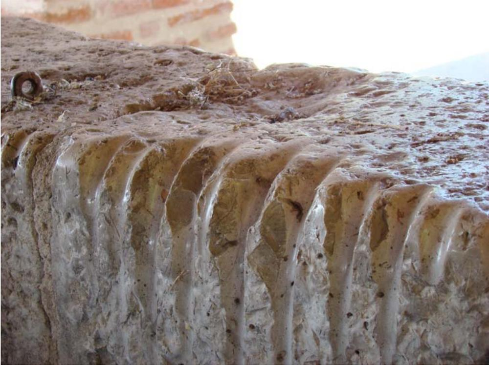
Detalle del brocal del pozo Bueno, de Serrada, en el que se aprecia el desgaste de la piedra por el roce de las cuerdas, aunque el pozo disponía de roldana o polea
