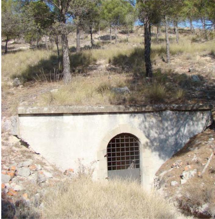
Boca del túnel de 600 metros por el que va la canalización de agua de 1917 para abastecer la fuente Techa de Castronuevo de Esgueva
